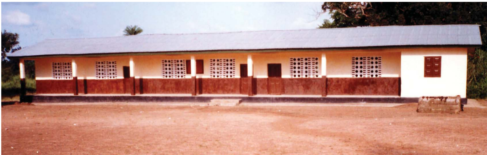
Struttura scolastica in Sierra Leone, composta da tre aule e un ufficio
